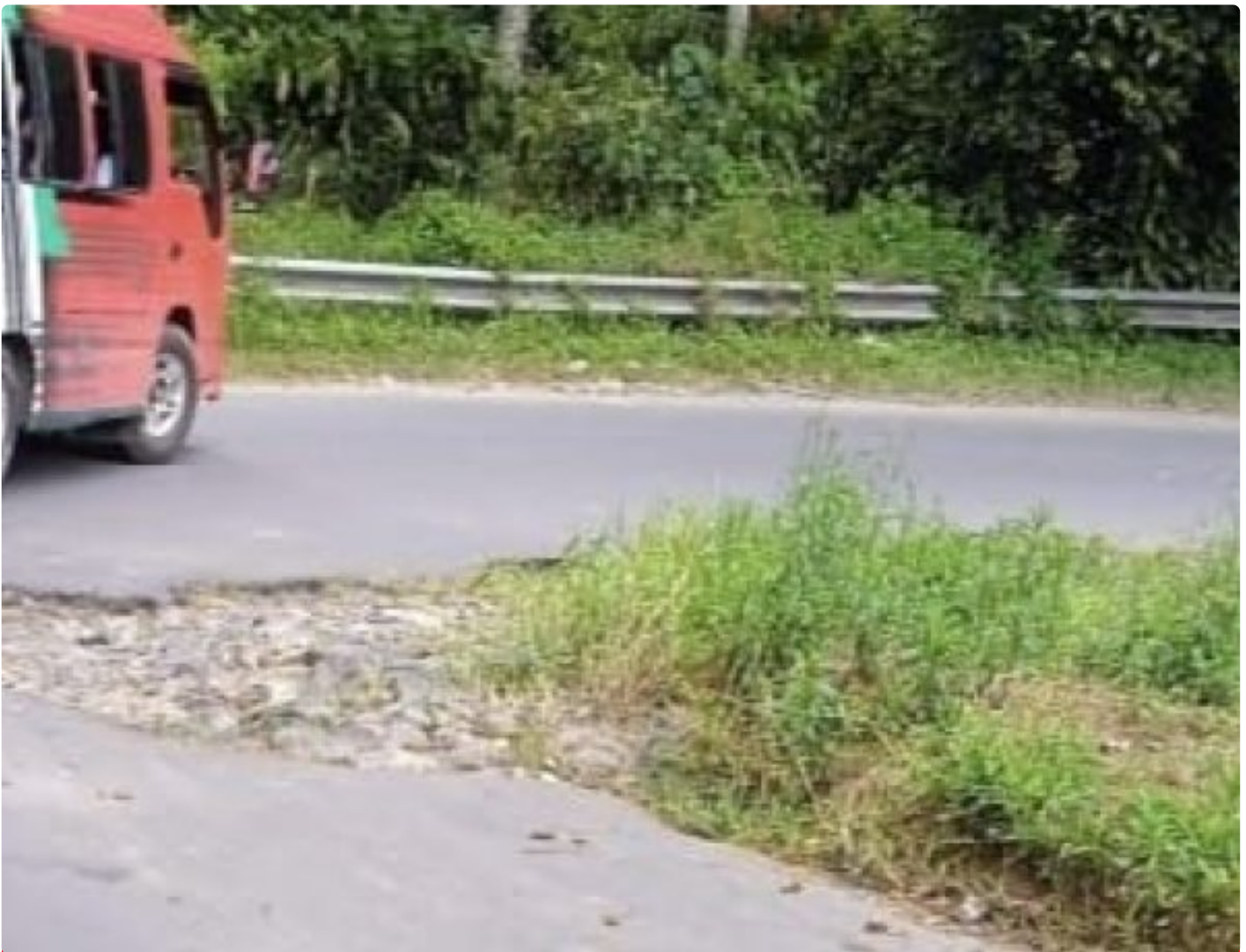
Jalan Provinsi ke Pelabuhan Penyeberangan Tigaras
